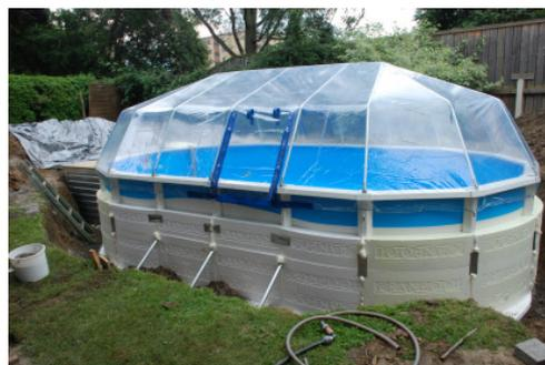
Die Schweißnähte der Sonnendomfolie sind versetzt zum Sonnendom-Gestänge angeordnet.
